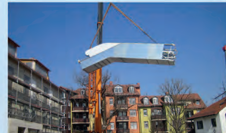
Einbau der Rolltreppe am Helmut-Karl-Platz während der Bauarbeiten
