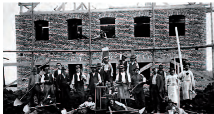
Hacker Baustelle in Handarbeit
